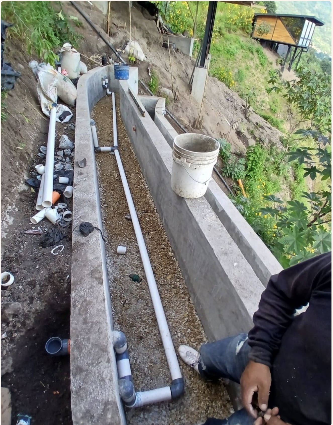
Terrazas de concreto en pendiente fuerte, que sirven al mismo tiempo de estructura, de jardinera y de humedal. En terreno inclinado, cada obra debe hacer varios trabajos a la vez.
